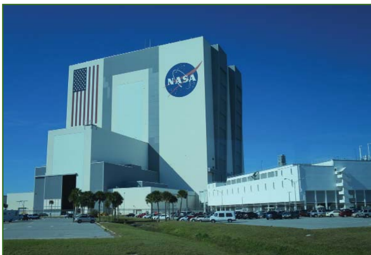
Рис. 2 Общий вид здания вертикальной сборки космодрома
